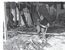
建物内の瓦礫を撤去 (宮城県)
